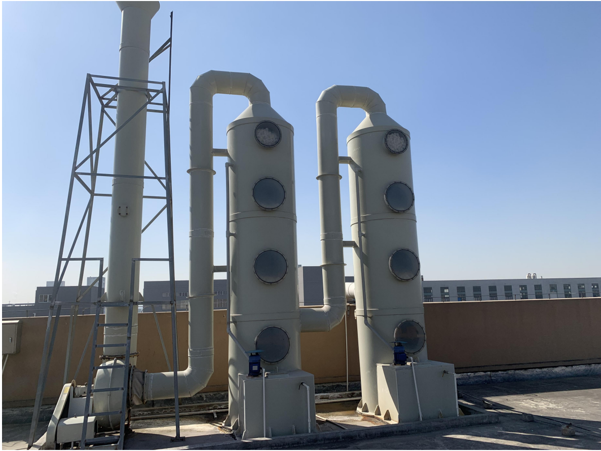
图 4.1-4 储罐区废气处理装置
