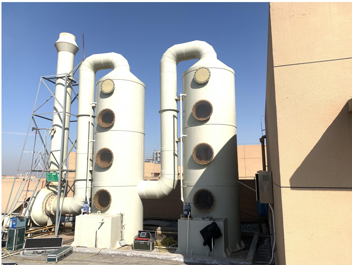
图 4.1-3 工艺废气处理装置及排污标志牌
