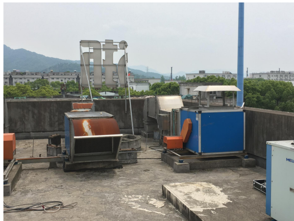
图 4.1-5 楼顶燃料废气排放口
