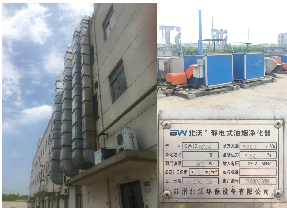
图 4.1-6 油烟净化处理装置
