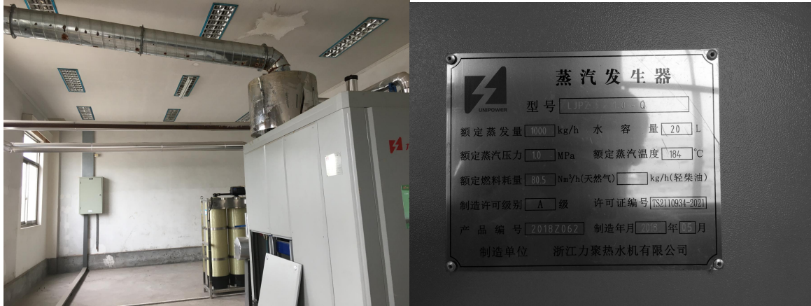
图 4.1-3 项目蒸汽锅炉
