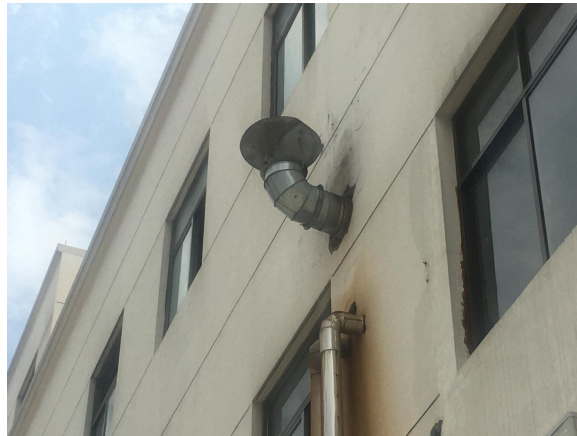
图 4.1-4 蒸汽锅炉废气排放口
